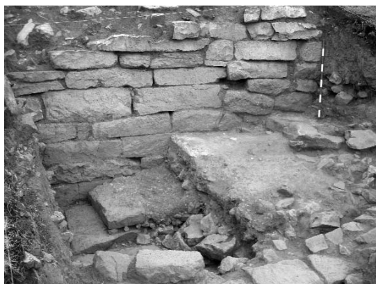
Figura 6.- Escalera de piedra adosada al lienzo interior de la muralla 1.
